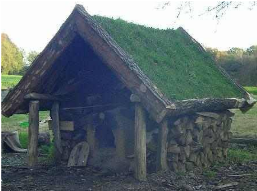
Der Lehmkuppelofen unter seinem Grasdach
