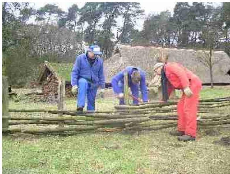
Januar 2006: Baubeginn für die Einhegung als Grenze zum Blekker-Hof
